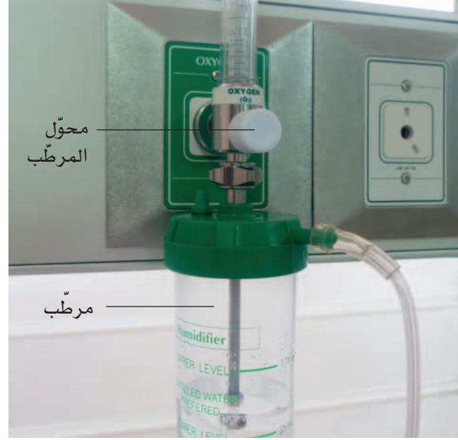
الشكل "3-57أ" عندما يُضخ الأكسجين عبر الحائط، يوصل مقياس التدفق بمحلول الحائط. يستخدم المرطب لترطيب الأكسجين.
