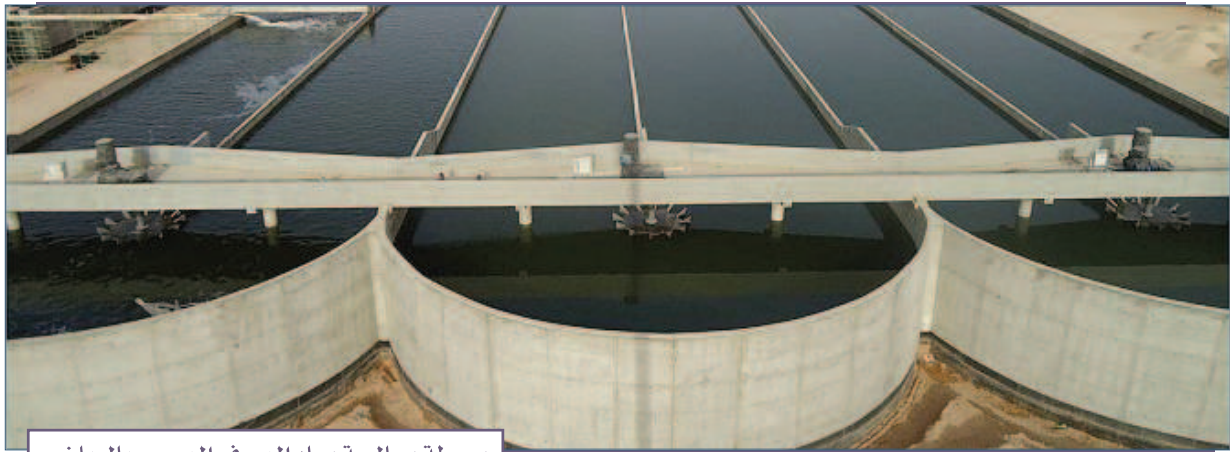
محطة معالجة مياه الصرف الصحي بالرياض
