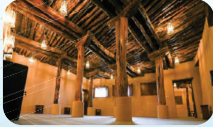
مسجد تاريخي بعد ترميمه
