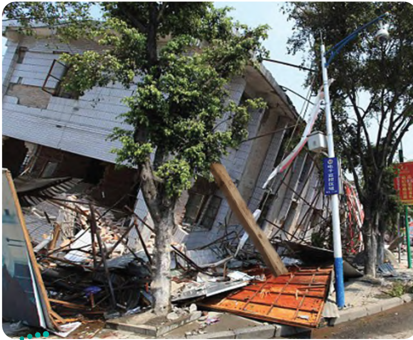
الشكل 32-6 المباني الخرسانية (الأسمتية) هشة غالباً، ويمكن أن تتلف بسهولة إذا وقع زلزال؛ فالمبنى الظاهر في الصورة أزيح من فوق أساسه عندما حدث الزلزال، وتم إسناده بعمود من الخشب.
